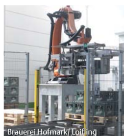
Brauerei Hofmark/Loifling RST-Roboter-Ent- und Bepalettieranlage mit Palettenhandling
